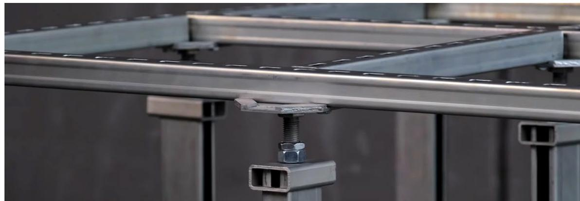
После установки ограничителей горизонтального хода раскладывается ряд панелей пола, производится точная регулировка по уровню при помощи лазерного уровня и затягиваются контргайки на опорных столиках. Самая тонкая регулировка панелей выполняется наклеиванием алюминиевых наклеек на страт-профиль. Далее этот цикл повторяется со следующими рядами балок и панелей.
